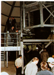
Innenansicht des Wettereintrittsgebäudes – Fischweilerschacht 8
