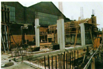
Bau einer Hydraulikwerkstatt
