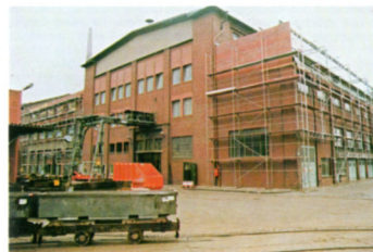
Teilaufstockung des Verwaltungsgebäudes
