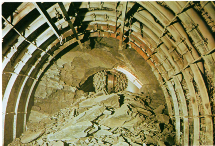
Durchschlag der Teilschnittmaschine vom Typ WAV 300 auf der Schachtanlage Westerholt/Pößum
