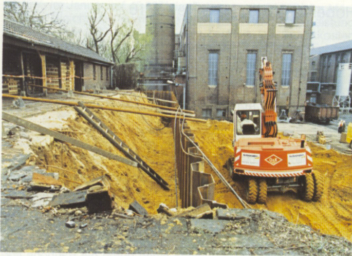
Baustelle des neuen Heizkraftwerkes
