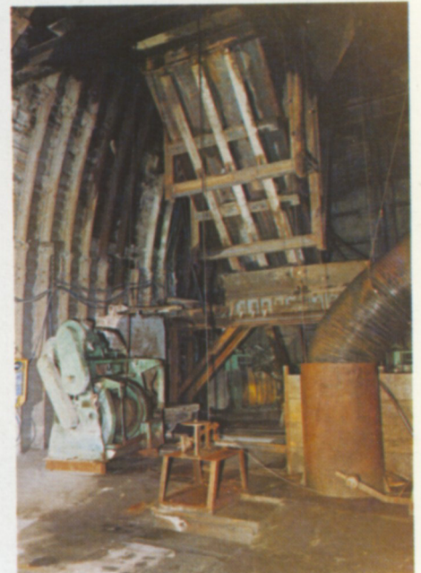
Kübelkippschurre im Blindschachtturm
