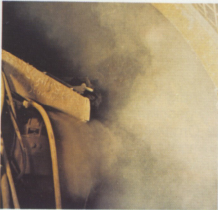
Intensive Staubbekämpfung im Bereich des Schneidkopfes einer Teilschnittmaschine
