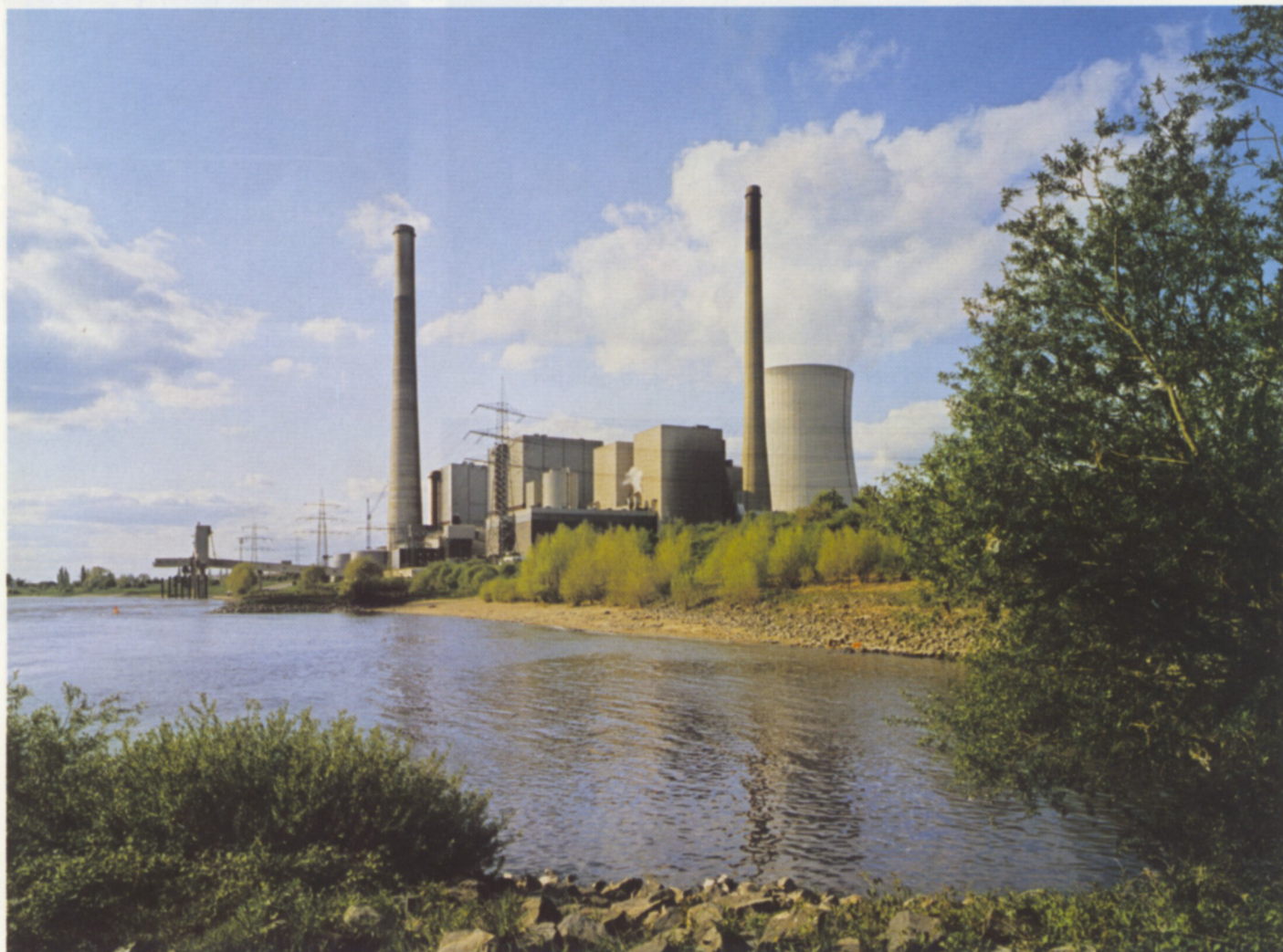
Gemeinschaftskraftwerk West: im Vordergrund die Blöcke I und II
