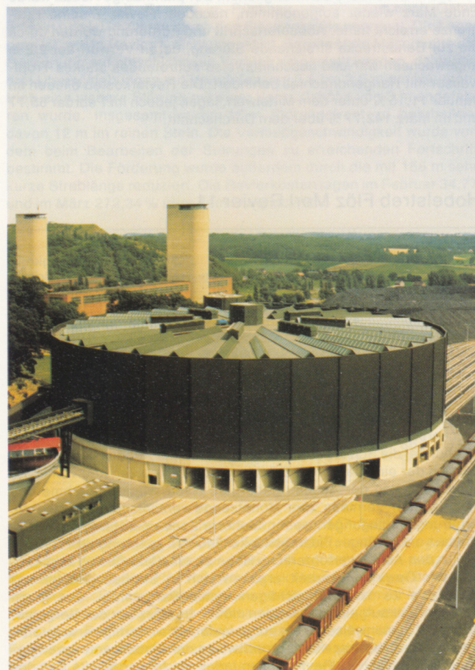
Die neue Aufbereitung an der Zentralschachtenlage
