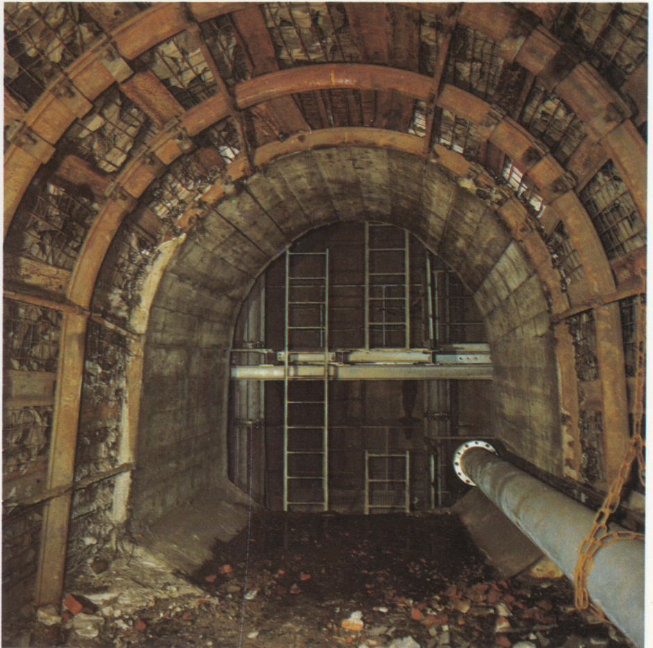
Wasserschloß (in der Bauphase)
