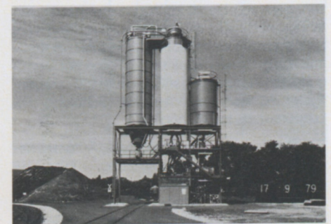
Bild 4: Anlage zur Herstellung von Fluicit
