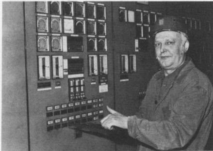
Am Arbeitsplatz Kesselhaus
