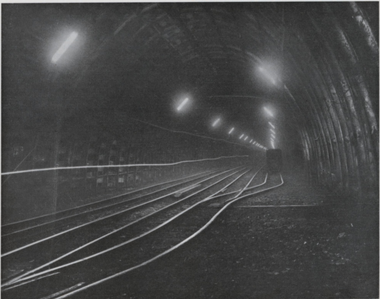
Füllort Schacht 4, vierte Sohle
