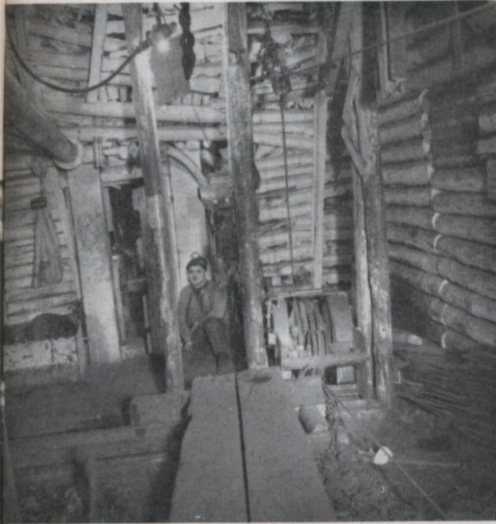
Hängebahn-, Kuli- bzw. Seilbahnantrieb mit dreirilliger Treibscheibe
