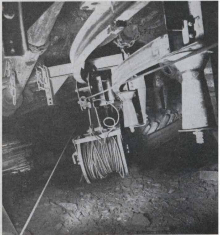
Die Laufkatzen der Hängebahn mit eingebautem Hubzug und Reserve-seiltrommel
