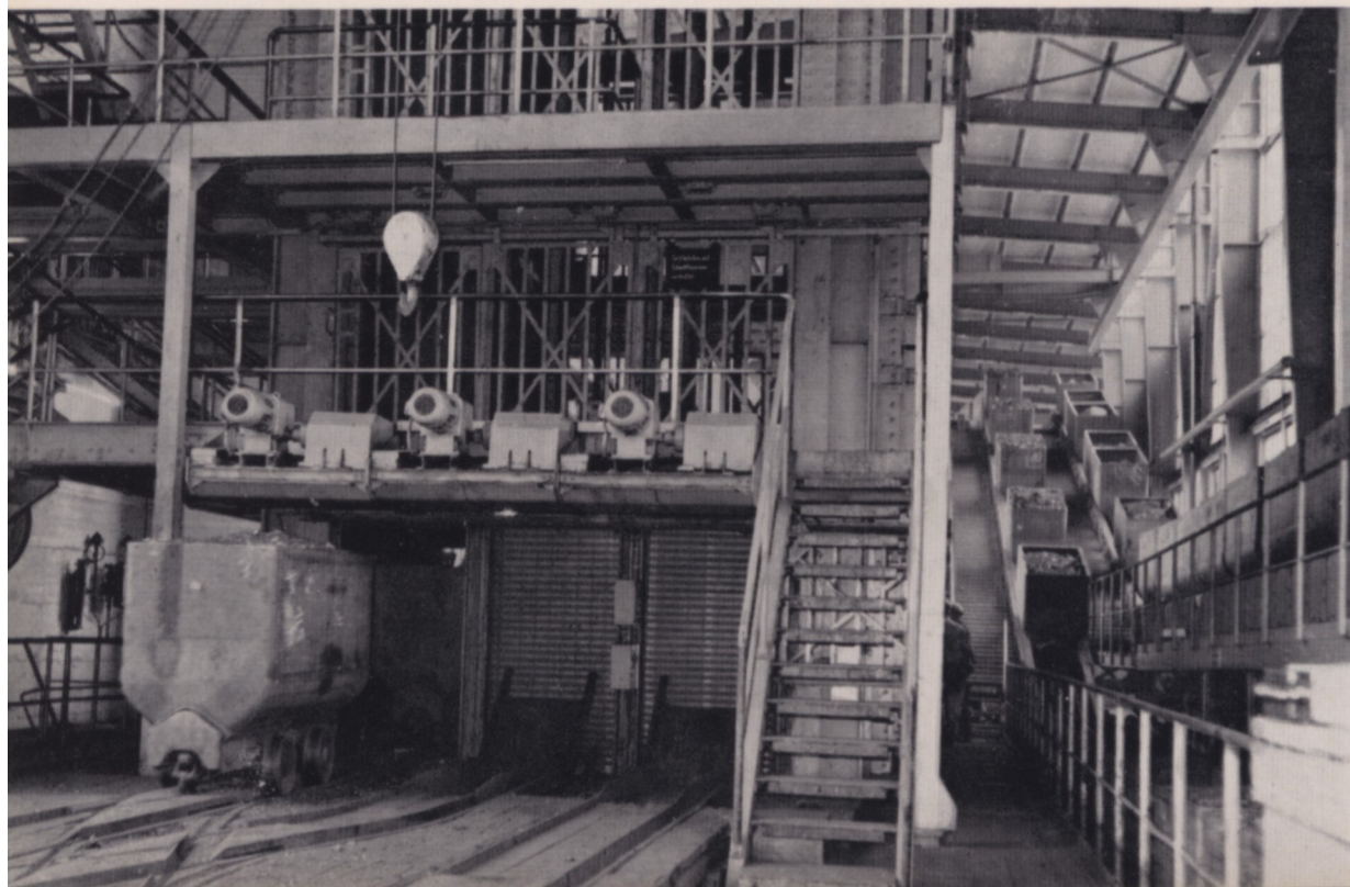
Hängebank Schacht IV mit Wagenumlauf
