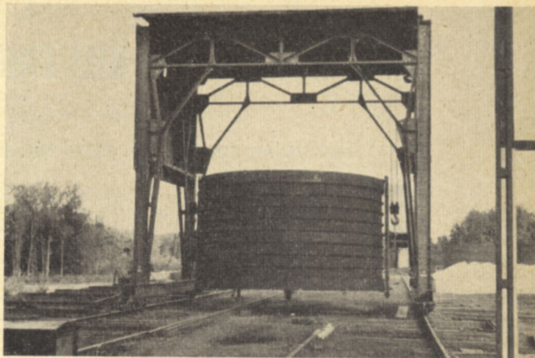
Der Bockkran bringt die fertigen Schüsse zum Lagerplatz
