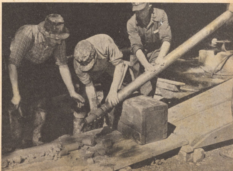
Herausnehmen von Kernen aus dem Kernrohr
