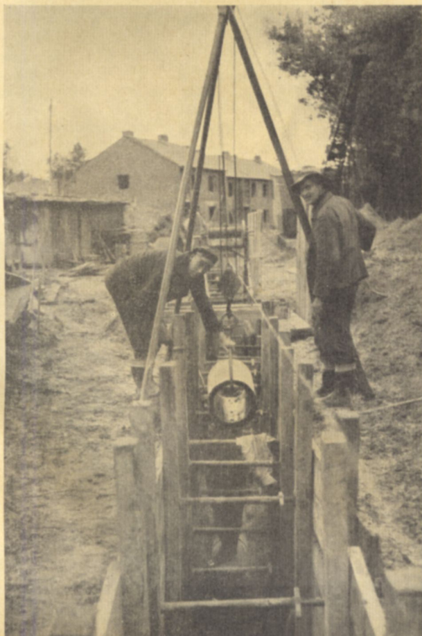
Verlegung der Abwasserleitung
