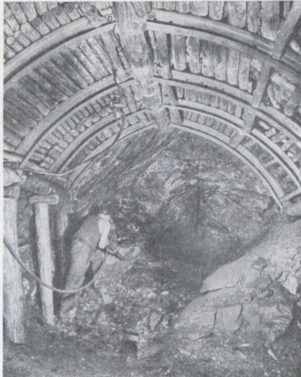
Eine Abbaustrecke wird vorgetrieben
