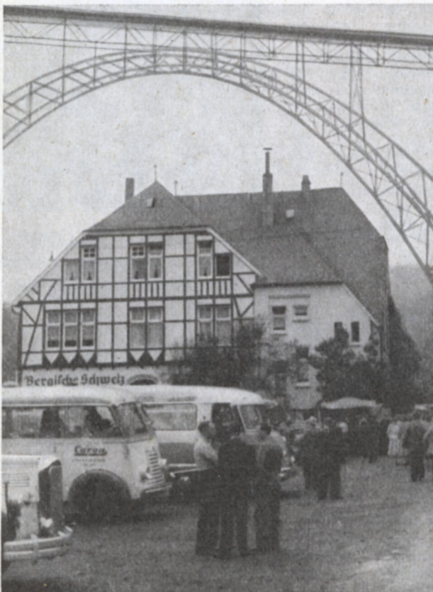
Die Müngstener Brücke
