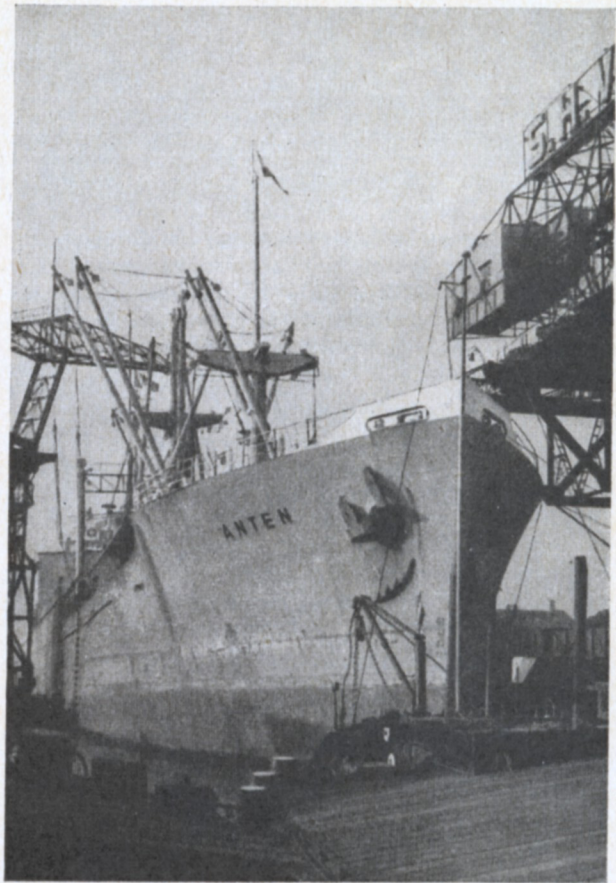
Dampfer „Anten“ übernimmt 1000 t Elektroden-Anthrazit. Die Eisenkonstruktion rechts oben gehört zum großen Verladekran der SHV Links der Ausleger eines Schwimmkrans
