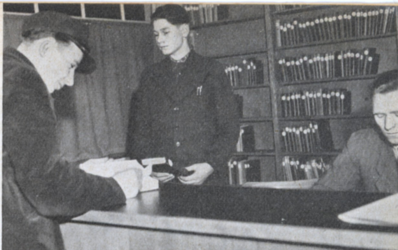
Blick in den neuerrichteten Ausgaberaum an Schacht IV
